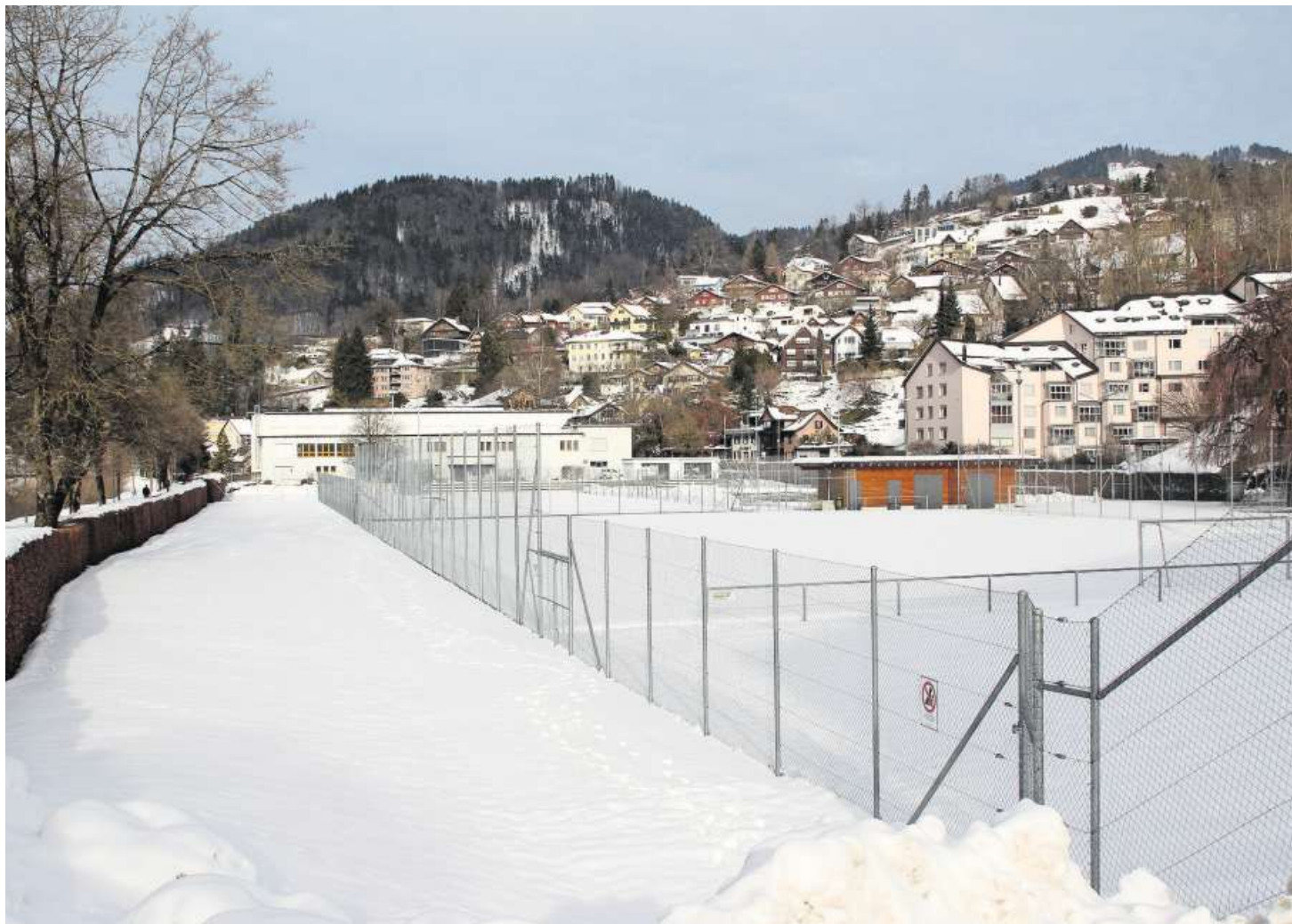
Auf diesem Areal soll die neue Kanti Wattwil erstellt werden. Das Areal liegt im Kataster belasteter Standorte.
