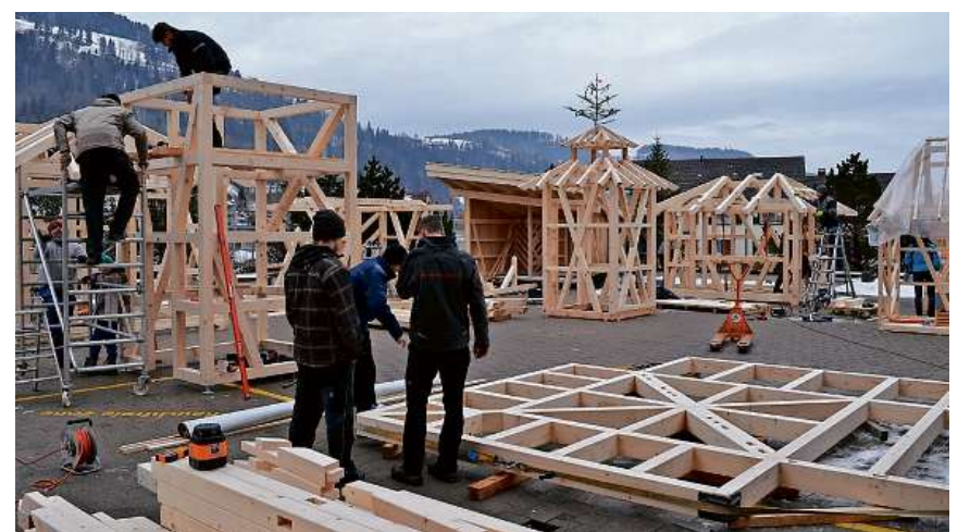
Noch wird aufgebaut: Auf dem Gelände des BWZT zeigen die angehenden Zimmerleute ihre wunderbaren Arbeiten aus Holz.
