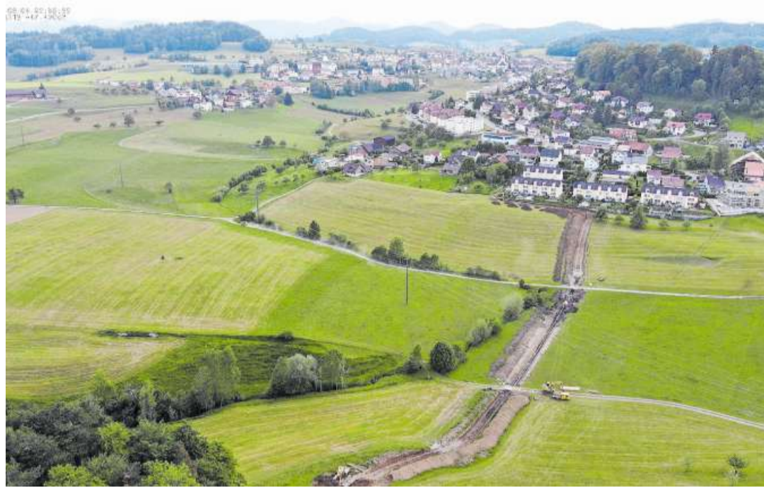
Vorne die bereits verlegten Fernwärmerohre ab dem Bazenhaid Energiepark. Rechts hinten Wolfikon. Oben hinten das Dorf Kirchberg. Bild: PD
