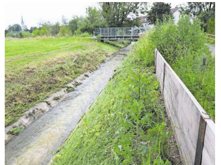
Rickenbach: Die höher gelegte Brücke über den Krebsbach sowie der erhöhte Schutzwall mit auslaufender Bretterwand haben gewirkt.
