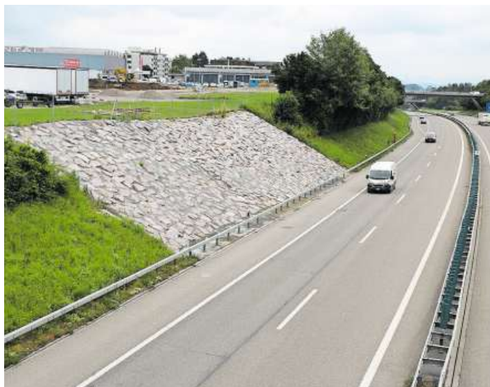
Wil: Das mit einbetonierten Felsbrocken gesicherte Autobahnbord an der A1 funktioniert: Es wurde kein Erdreich auf die Autobahn gespült.
