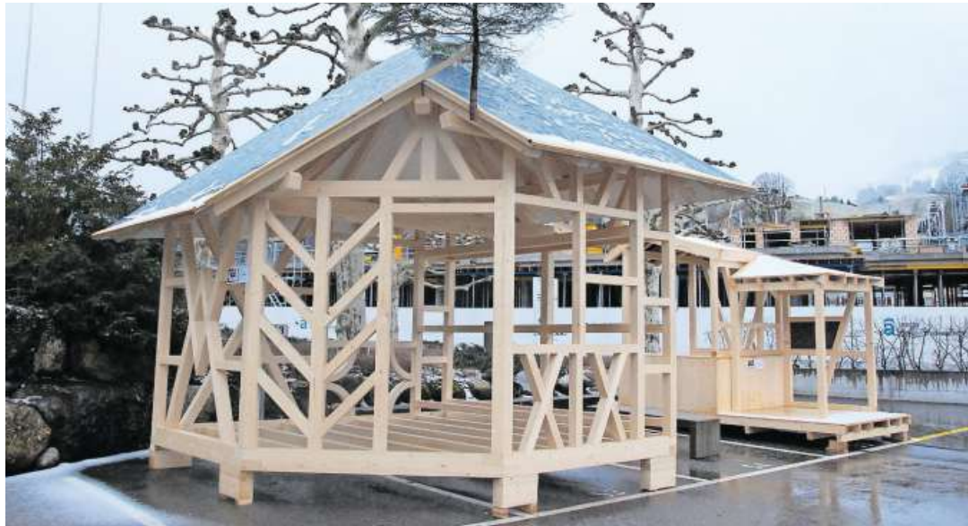
Teils wurden die Bauten mit einem Kran auf den Platz gehievt.
