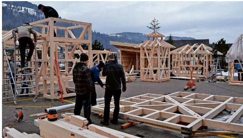
Noch wird aufgebaut: Auf dem Gelände des BWZT zeigen die angehenden Zimmerleute ihre wunderbaren Arbeiten aus Holz.
